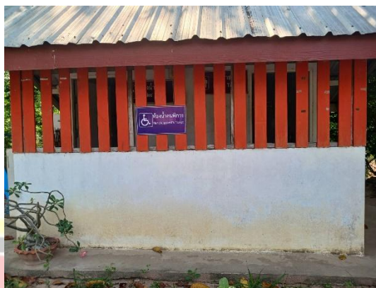
ห้องน้ำผู้พิการแยกออกมาต่างหากจากห้องน้ำ
